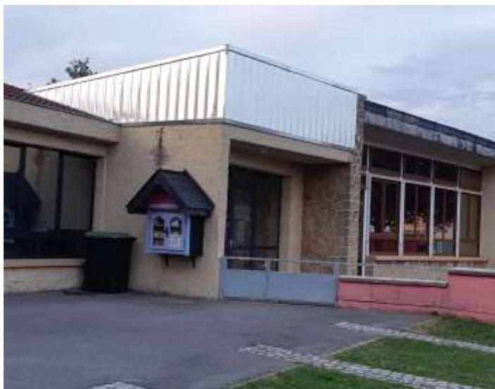
Une nouvelle toiture a été mise en place sur le toit du périscolaire. En effet précédemment il y avait une toiture terrasse qui avec le temps n'était plus étanche, outre les infiltrations à répétition, cela demandait des travaux d'entretien coûteux. Nous avons décidé de mettre en place une nouvelle toiture afin de résoudre ces problèmes.
